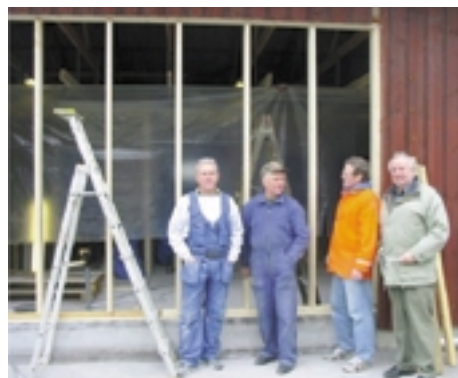
Porten är såld och hålet skall täppas till. Reglarna är på plats, arbetslaget tar en paus tillsammans med Bengt.
