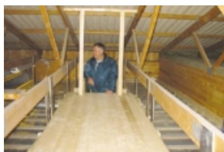
Mats inspekterar vindsutrymmet.
