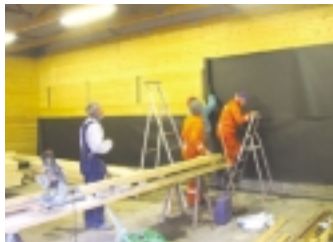
Ytterväggarna kläs med förhydningspapp. Krister spikar takbräder.
