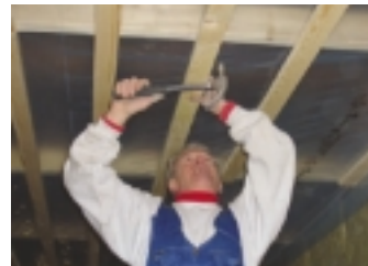
Ytterväggarna kläs med förhydningspapp. Krister spikar takbräder.
