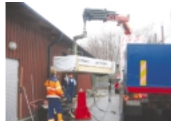
Leverans av trävirke till taket.
